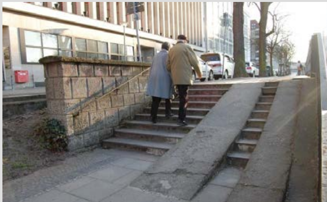
Treppenanlage Märkisches Ufer
