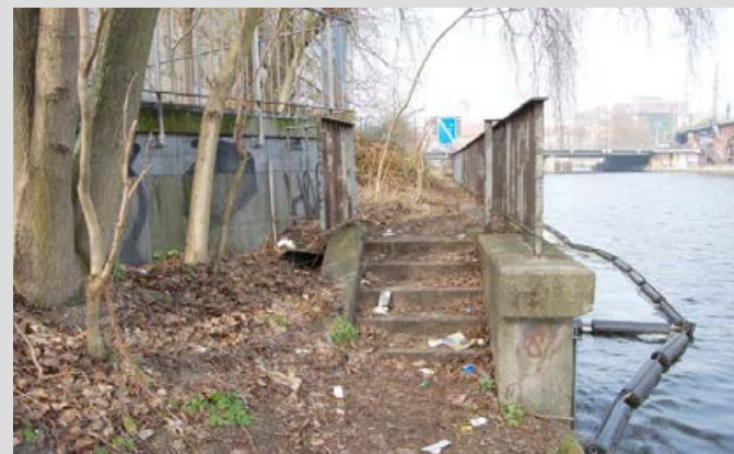
Rungestraße 21 (Kühlwasserauslauf HKW)
